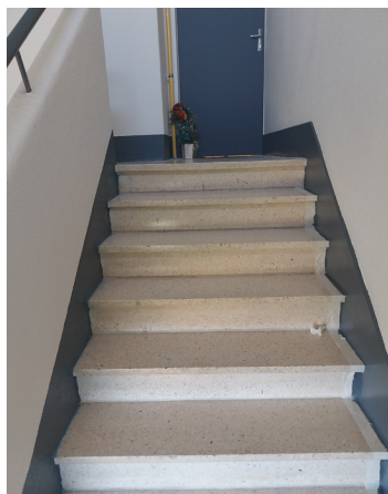
● Logements à Saint-Vaury Réfection des cages d'escalier
