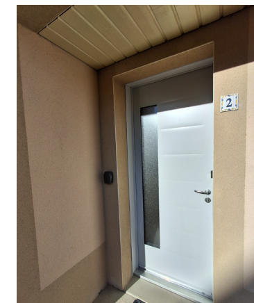
● Logements à Ahun Changement des menuiseries
