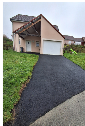
● Logements à Évaux-Les-Bains Réfection des allées de garage
