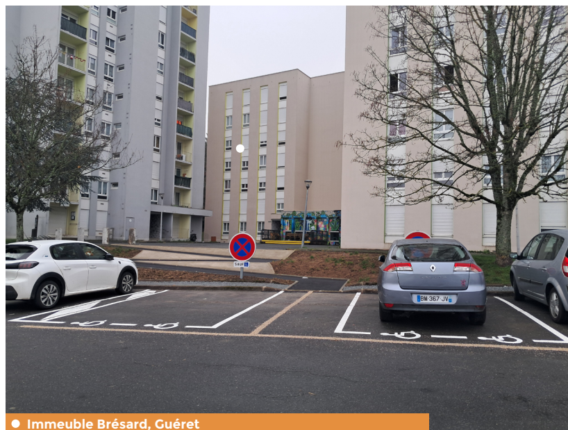
● Immeuble Brésard, Guéret Création de stationnement pour personnes handicapées
