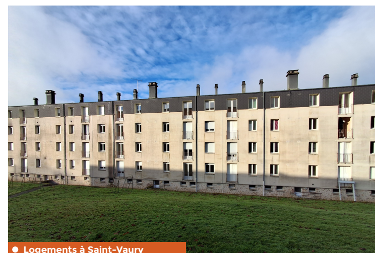
● Logements à Saint-Vaury Changement des menuiseries
